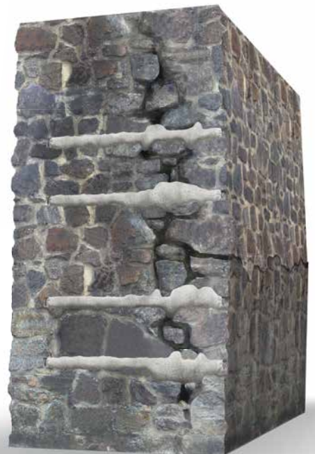
Anbindung abgelöster Mauerwerkschalen Raccordement des murs séparés
