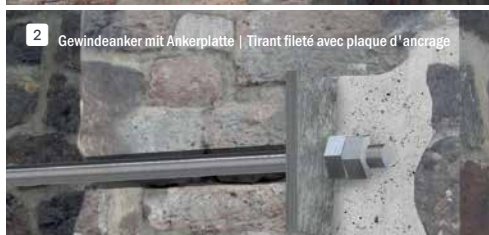
Detail: Einbau mit Verbundwirkung Détail: installation avec effet d'adhérence
