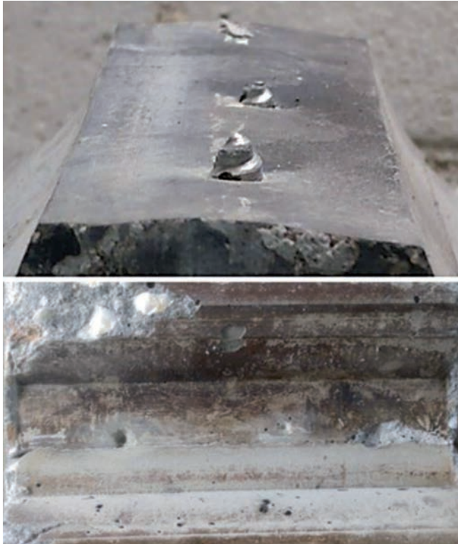
Bild 9 Durchbohren des Fugenbands mit der Gewindenadel (oben) und Betonoberfläche hinter dem Fugenband (unten) Penetration of the joint tape by threaded needle (top) and concrete surface behind the joint tape (bottom)
