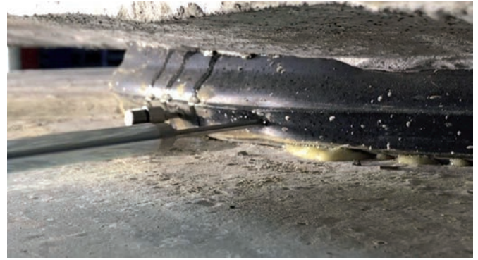
Bild 4 Setzen einer Injektionsbohrnadel Insertion of an injection drilling needle
