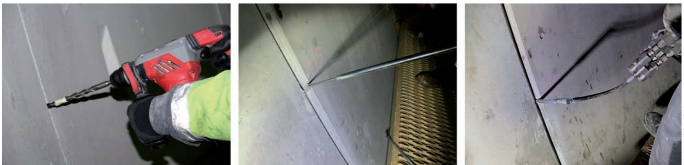
Bild 2 Vorgehen bei der minimalinvasiven Fugensanierung Process of minimally invasive joint restoration
