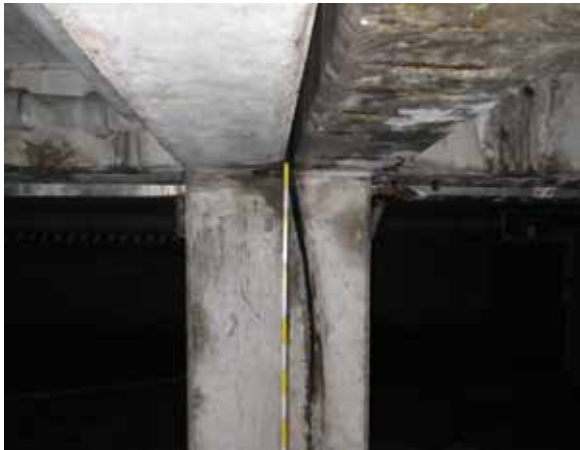
Raumfuge in Unterzug und Stütze
